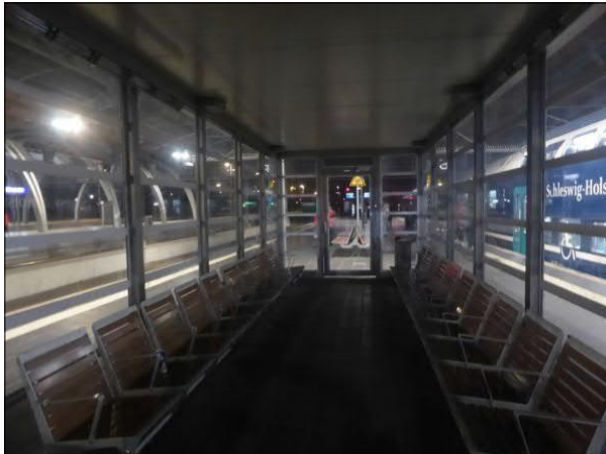
Abbildung 15: Wie bereits vor einem Jahr waren die im Jahr 2023 errichteten Warteräume auf den Bahnsteigen in Lübeck Hbf auch in diesem Winter unbeheizt und unbeleuchtet.
