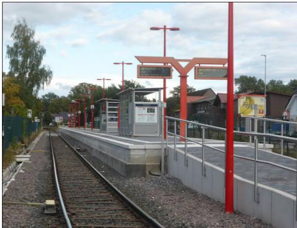
Abbildung 6: Die Bahnsteige in Ellerau (Foto) und Tannenack wurden im 1. Halbjahr 2025 erneuert. Dabei wurden die Bahnsteigdächer abgebaut und durch Unterstände ersetzt.
