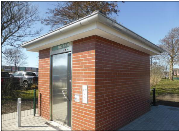
Abbildung 36: In Klanxbüll wurde Anfang 2025 die nur zeitweise nutzbare WC-Anlage im Bahnhofsgebäude durch eine barrierefrei und kostenlos nutzbare WC-Anlage am P+R-Platz ersetzt.
