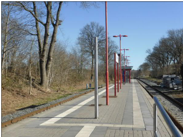
Abbildung 31: In Großenaspe wurden die Uhren an beiden Bahnsteigenden abgebaut.
