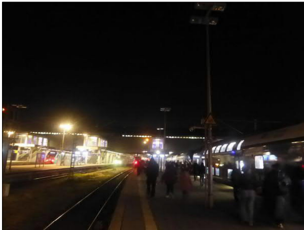
Abbildung 13: In Lübeck Hbf waren am 22.11.2025 in den Bereichen außerhalb der Halle fast alle Leuchten der Lichtmasten auf den Bahnsteigen defekt.
