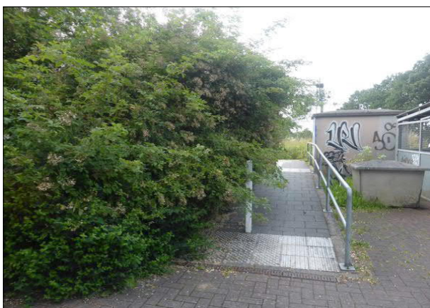
Abbildung 41: Im Juni war der einzige Zugang zum Bahnsteig in Gokels weitgehend zugewuchert.
