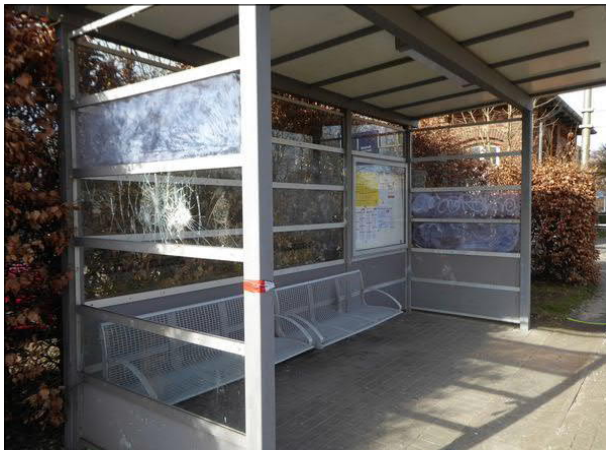
Abbildung 39: Dieser Unterstand an Gleis 1 in Krempe wies im Frühjahr sowohl Glasschäden als auch flächig zerkratzte Kunststoffscheiben auf.
