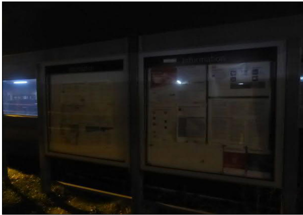
Abbildung 24: Die im Jahr 2024 erneuerten Vitriken am Zugang zu Gleis 1 in Dauenhof waren im 4. Quartal 2025 nicht beleuchtet, so dass die Aushänge bei Dunkelheit nicht lesbar waren.
