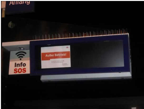
Abbildung 30: In Krupunder war der Zugzielanzeiger für Gleis 1 im vierten Quartal einseitig defekt.
