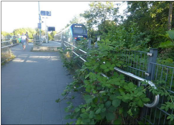
Abbildung 18: Der Handlauf am Zugang zu Gleis 3 in Eckernförde war im Sommer mit stacheligen Brombeerpflanzen überwuchert und damit unbenutzbar.
