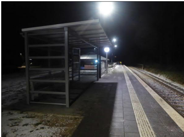
Abbildung 46: Einen großen Anteil an den trotz des neuen Bahnsteigs schlechten Bewertungen der Bahnstation Sierksdorf haben die nicht funktionierenden Beleuchtungen aller Wetterschutzeinrichtungen und Vitrinen.
