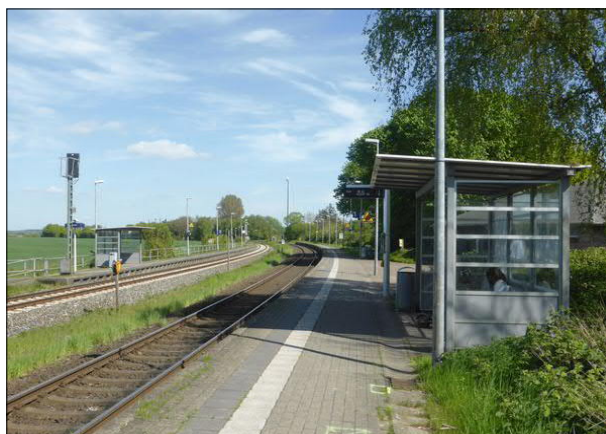
Abbildung 48: In Wilster war der Zustand des Fahrgastunterstands an Gleis 1 meistens unbefriedigend. Einige Scheiben sind flächig zerkratzt.
