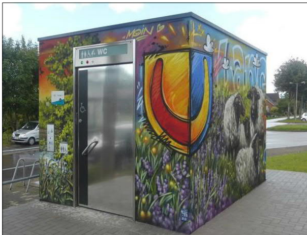
Abbildung 37: Im Sommer wurde von der Gemeinde Langenhorn am Bahnhof eine neue WC-Anlage errichtet. Die Fassade wurde mit lokalen Motiven gestaltet.
