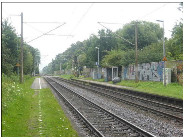
Abbildung 47: Die Station Kupfermühle mit niedrigem Ausstattungsniveau ist durch zahlreiche Schmierereien am Wetterschutz, an der Lärmschutzwand und an den Schaltschaltern geprägt.
