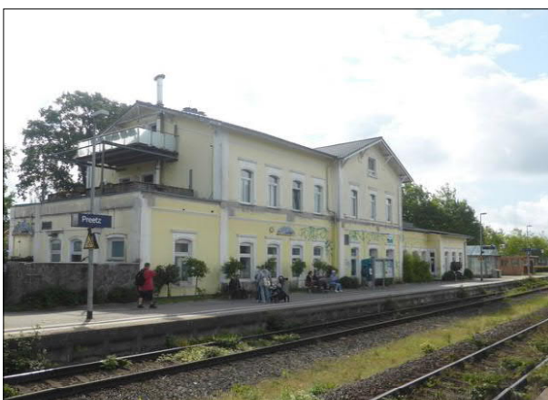
Abbildung 5: In Preetz wurde im 4. Quartal 2024 das Bahnsteigdach an Gleis 1 abgebaut. Erst im 2. Quartal 2025 wurde mit einem unbeleuchteten Holzunterstand (am rechten Bildrand) wieder ein Wetterschutz hergestellt. Beleuchtung gibt es seit dem Dachabriss vor dem Bahnhofsgebäude lediglich in den Vitrinen. Wettergeschützte Sitzplätze sind auf diesem Bahnsteig nicht mehr vorhanden.
