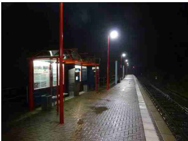
Abbildung 3: Die moderne LED-Beleuchtung am Haltepunkt Holstenherme führte zu einem sehr guten Ergebnis. Die Station war ohne Mängel.
