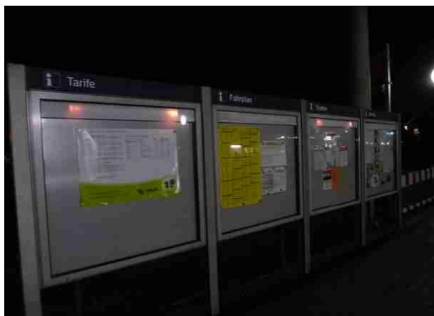
Abbildung 28: Das Glimmen in zwei Vitrinen des Infopunkts in Bordesholm zeigt, dass Strom vorhanden ist. Offensichtlich sind alle Leuchtmittel defekt.
