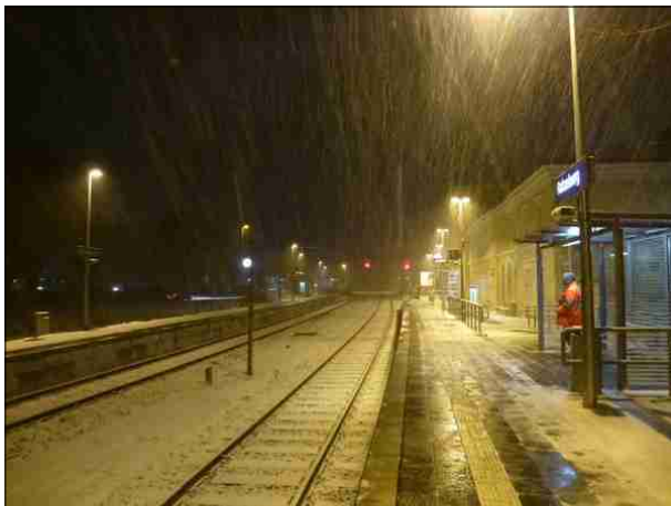
Abbildung 1: Der Hausbahnsteig in Ratzeburg ist erneuert worden. Dabei wurde auch die Höhe an die Fahrzeugeinstiege angepasst.
