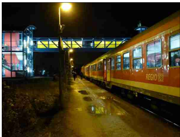
Abbildung 4: Auf dem Bahnsteig an Gleis 2 in Tornesch bildeten sich durch abgetragenen Belag tiefere Pfützen.
