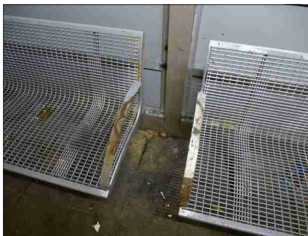
Abbildung 12: Die Bänke in Bad St. Peter Süd sind weiterhin erheblich angerostet, teilweise angekockelt und verschmutzt.
