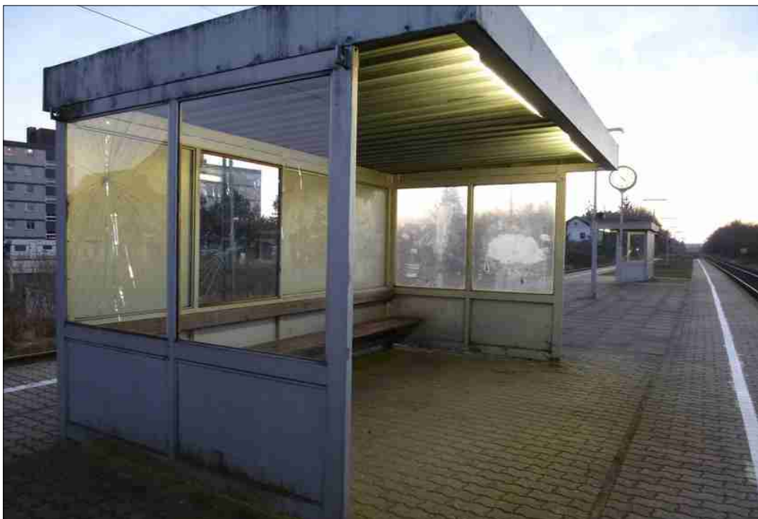
Flensburg-Weiche: Bahnhof an der Strecke Hamburg - Flensburg: Keine der Scheiben in den Fahrgastunterständen war unbeschädigt. Eine Scheibe des hinteren Unterstands fehlte sogar.
