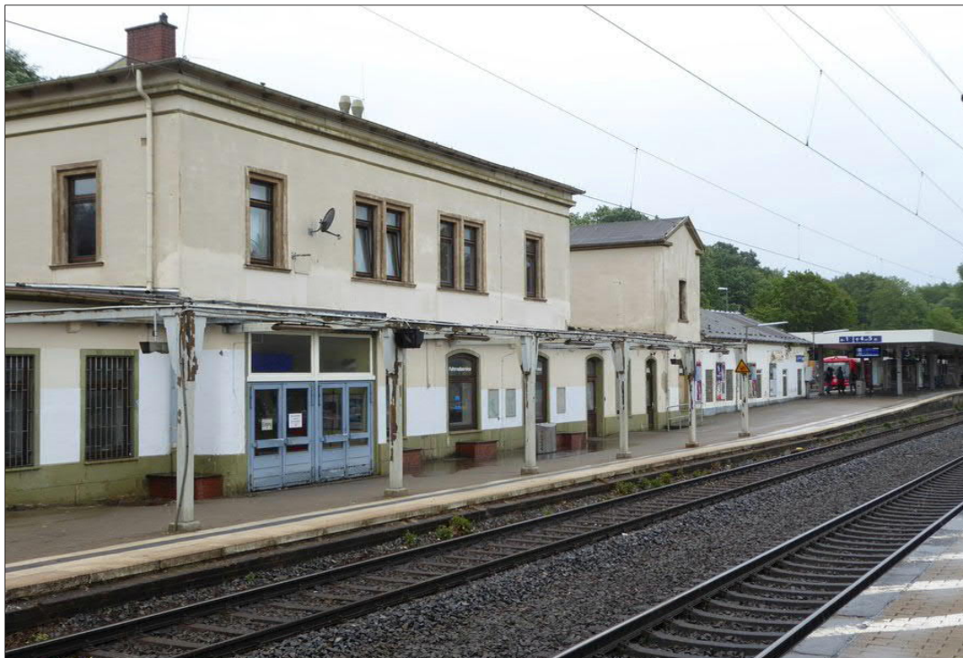
Pinneberg: Bahnhof an der Strecke Elmshorn - Hamburg. Das Bahnhofsgebäude in Pinneberg war gesperrt. Auch an den Bahnsteigen, den Treppeneinhausungen und an zwei Zugzielanzeigern wurden Schäden erfasst.
