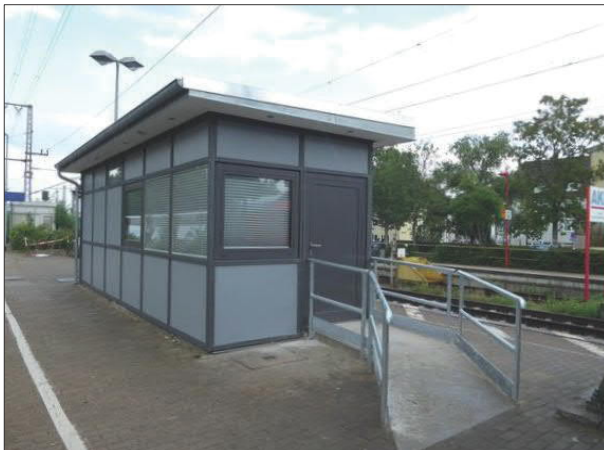
Abbildung 59: In Elmshorn gibt es seit diesem Sommer Mitarbeiter für Bahnsteigservice. Der Dienstraum wurde auf dem Mittelbahnsteig hergerichtet.
