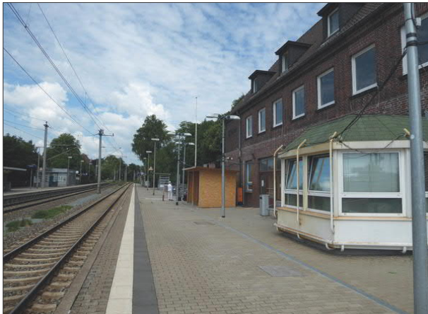
Abbildung 7: Mit dem Wiederaufbau des im Oktober 2015 zur Erneuerung abgebauten Bahnsteigdaches in Glückstadt war Mitte Juli 2018 noch nicht begonnen worden. Eine aktuelle Information zur Maßnahme gab es vor Ort nicht.
