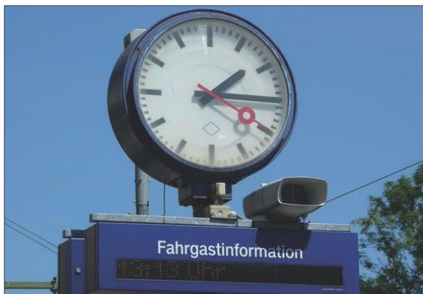
Abbildung 22: Die Zeiger der Uhr in Bargteheide waren auf einer Seite etwas verdreht. Der direkt darunter installierte DSA zeigt die korrekte Zeit: 13:13 Uhr.
