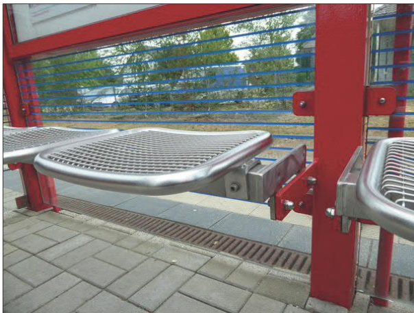
Abbildung 13: Für die zu niedrigen Sitze in Lentföhrden wurde eine neue Befestigung entwickelt. Dadurch entsprechen sie jetzt der Sollhöhe von 45-46 cm über dem Bahnsteig.
