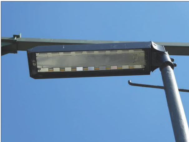
Abbildung 50: In Bad Oldesloe wurden die meisten Lichtköpfe an den Gleisen 4 und 5 durch LED-Leuchten ersetzt.
