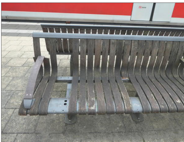
Abbildung 15: Einer verwitterten Bank auf dem Bahnsteig in Wohltorf fehlen einige Latten.
