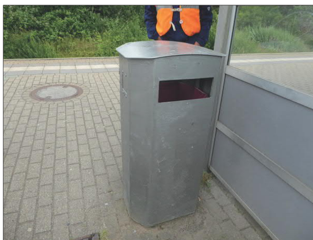
Abbildung 16: An einigen Stationen wurden großflächige Lackschäden und Rost an den Abfallbehältern übergestrichen. Das ist auch mit diesem Behälter in Bredstedt geschehen.
