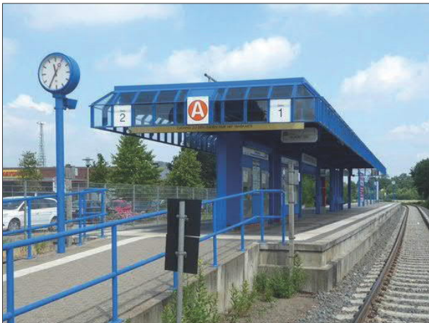
Abbildung 1: Eines der in diesem Jahr neu gestrichenen Bahnsteigdächer im Bereich der AKN ist das an der Station Quickborner Straße.
