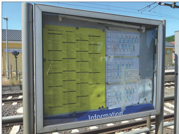
Abbildung 35: Die Vernachlässigung ist dieser Vitrine in Brokstedt anzusehen: Die Scheibe ist seit mehr als einem Jahr beschädigt, der Reiter ist heruntergefallen und die Leuchtstoffröhre fehlt.
