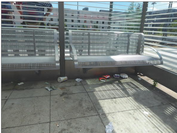
Abbildung 11: Die Sauberkeit in den Unterständen des Kieler Hauptbahnhofs war nicht zufriedenstellend.
