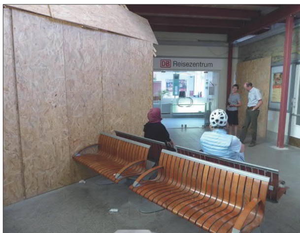
Abbildung 38: In Schleswig ist wieder ein kleiner Bereich im Gebäude nutzbar. Am Zugang zum Reisezentrum wurde eine Warteecke eingerichtet. Der Durchgang zum Bahnsteig ist nach wie vor gesperrt.
