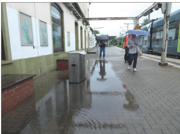
Abbildung 6: Auf dem Hausbahnsteig in Pinneberg hatte sich am 21.6.2018 eine große Pfütze gebildet.
